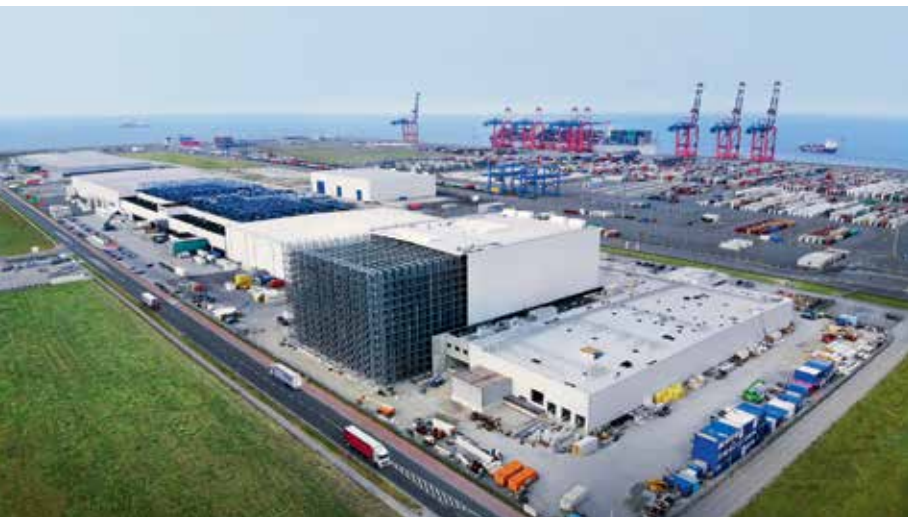
Das Hochregallager am Nordfrost Seehafen-Terminal in Wilhelmshaven wurde in rund 14 Monaten gebaut ist seit November 2021 im Betrieb.
